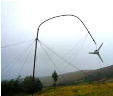
Fig. 58: Broken guy wires
