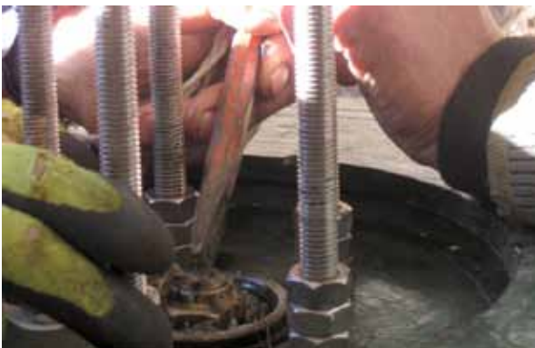
Fig. 41: Lock the nut
